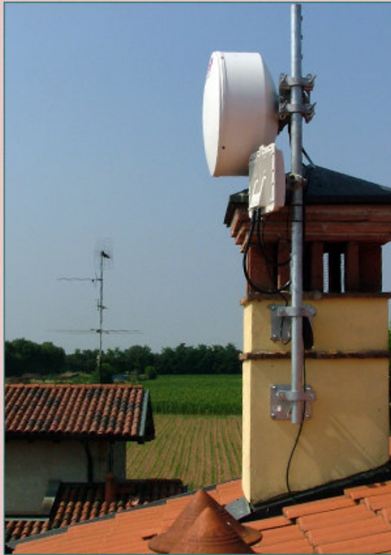
Apparato PTP500 con antenna RADIOWAVES
